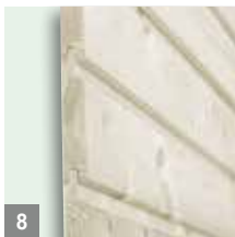
Profilbretter 19,5 x 96 mm, mit Nut und Feder
