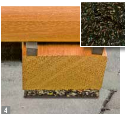
4 Gummi reguliert: Höhenausgleich-Pads für die Unterkonstruktion.
