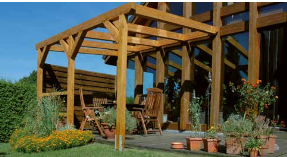
offenes Terrassendach aus Lärche - Leimholz, bauseits lasiert
