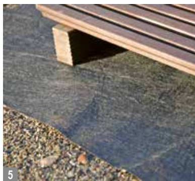
5 Wasserdurchlässiges Abdeckvlies gegen Durchwurzelung und Pfützenbildung.
