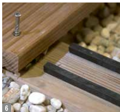
6 Praktisch: Selbstklebendes Ausgleichsband reguliert Unebenheiten.
