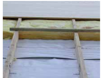
Das doppelschalige Dach für frostige Tage – zur Aufnahme der Dämmung vorbereitet. Aufpreis für Doppelschaliges Dach (für Aufdachdämmung): Dachsparren; zweite Dachschalung; Ortgang- und Traufbretter breiter
