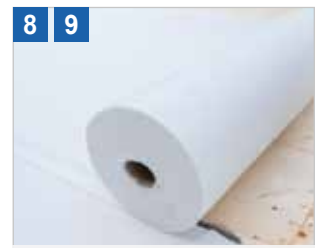
8) Erste Lage Vlies - 9) 22,5 x 96 mm Faserbretter Holzschalungsfläche
